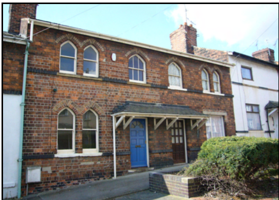
Nos. 5 & 6 Allport Terrace
